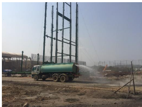
รูปที่ 2-2 การฉีดพรมน้ำ บริเวณพื้นที่ก่อสร้าง
